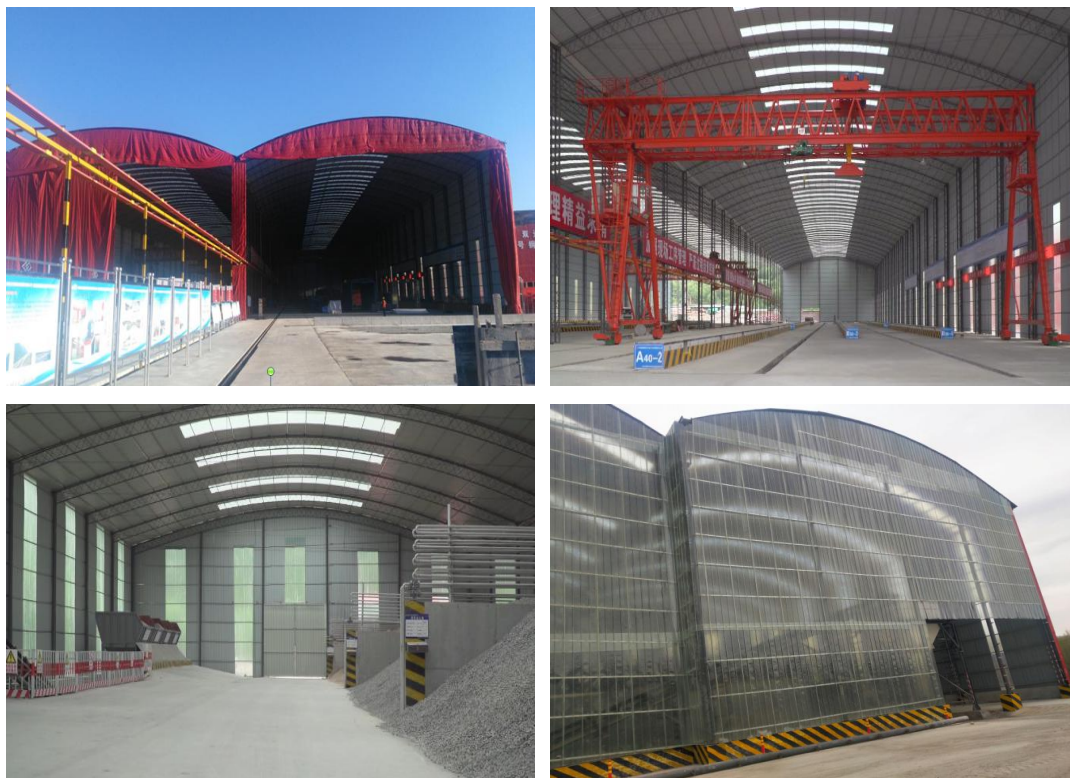
图 3.3-1 全封闭梁场、料仓
