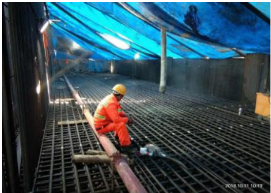
图 3.2-6 大体积承台暖棚保温施工
