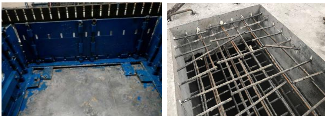
图 3.2-2 负弯矩槽口模板运用效果图
