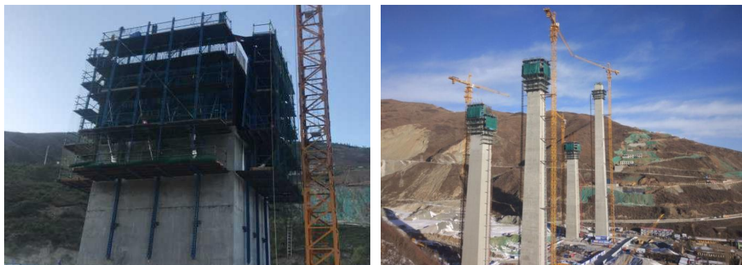
图 3.2-3 高墩整体式液压爬模
