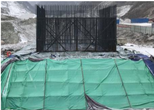
图 3.2-6 大体积承台暖棚保温施工
