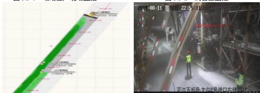
图 3.5-3 施工现场监控
