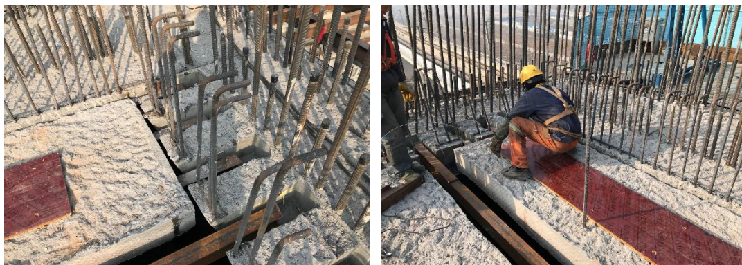
图 3.7-4 空心墩预制盖板安装
