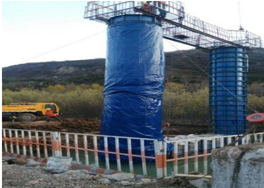
3.2-5 墩柱套筒蒸汽养生
