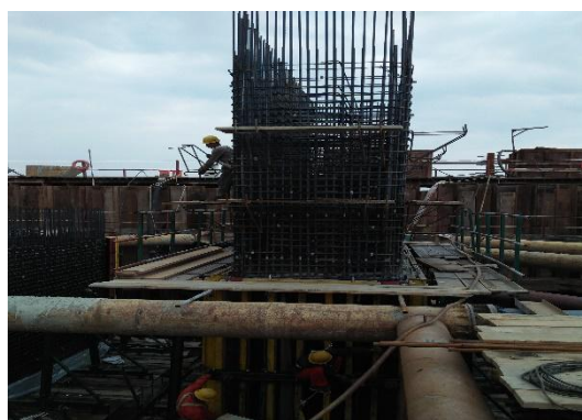
图 3.7-2 利用简易挂架完成上层钢筋绑扎
