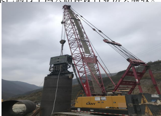
图 3.7-1 护筒跟进施工图
