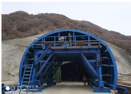
图 3.3-5 隧道 9.1m 二衬台车
