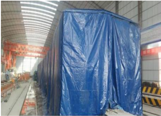
图 3.2-4 箱梁蒸汽养生图
