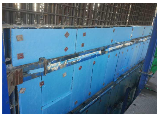
图 3.7-3 混凝土养护
