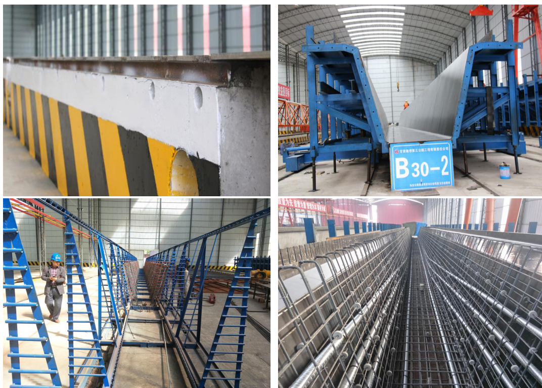
图 3.3-2 预制场标准化生产及施工
