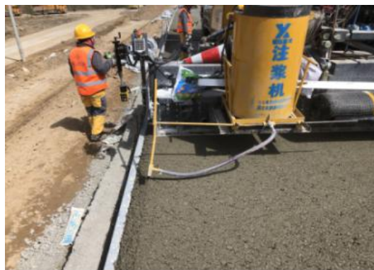
图 3.3-6 自动水泥边部注浆机
