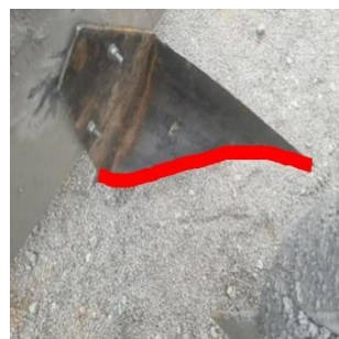
挡板下边缘圆滑连接
