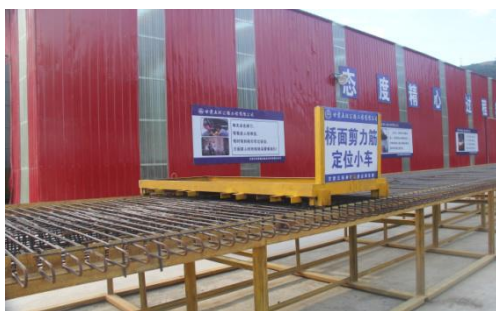
桥面剪力筋定位小车
