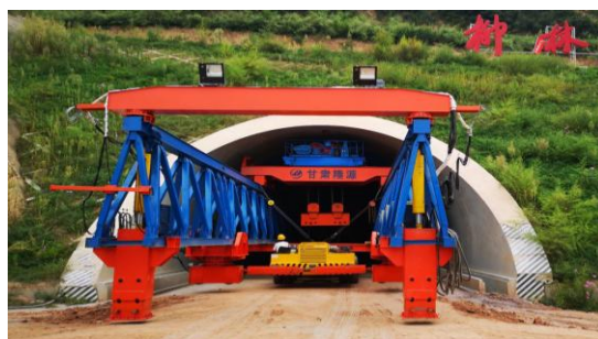
桥隧相连路段架桥机
