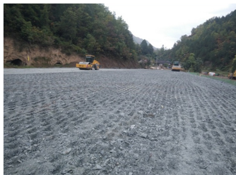
路基填筑“消化”隧道洞渣
