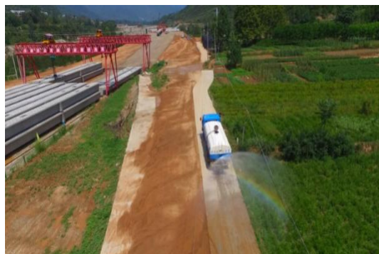
施工便道洒水降尘
