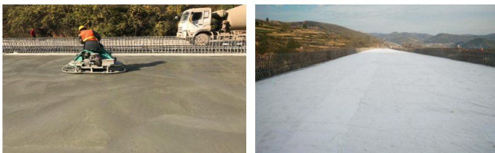
驾驶型抹光机压实、抹面、收光
