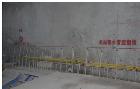
仰拱两侧预留钢筋定位架
