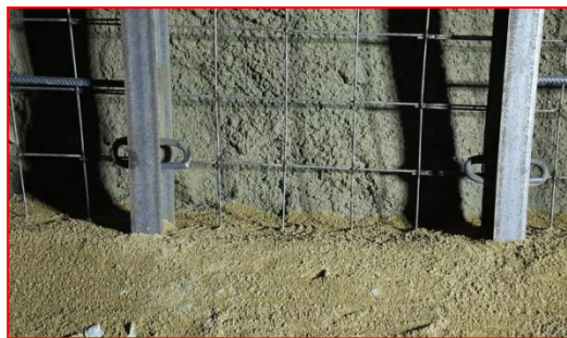
隧道拱架拱脚处支垫砂箱
