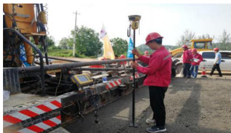
路面 mmGPS 3D 数字化自动摊铺
