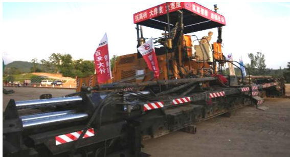
伸缩熨平板摊铺机
