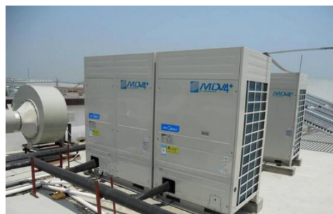
多联机空调屋面安装图
