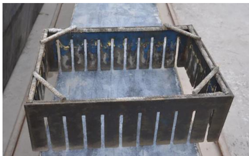
箱梁负弯矩槽口定型架
