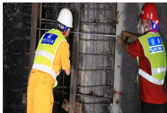
隧道初支全面验收制度
